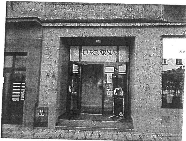
Nebytový prostor v 1. NP - vstup
