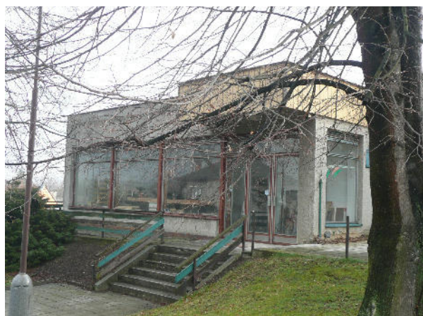
Stavba č. p. 79 – pohled JZ
