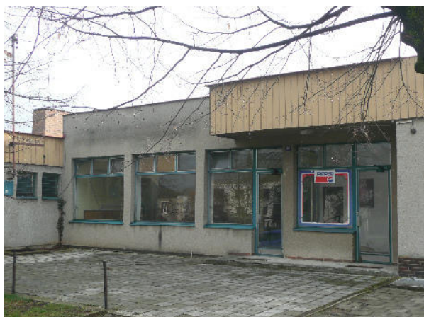
Stavba č. p. 80 – pohled JZ
