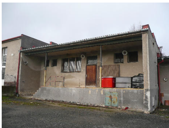
Stavba č. p. 80 – pohled SV
