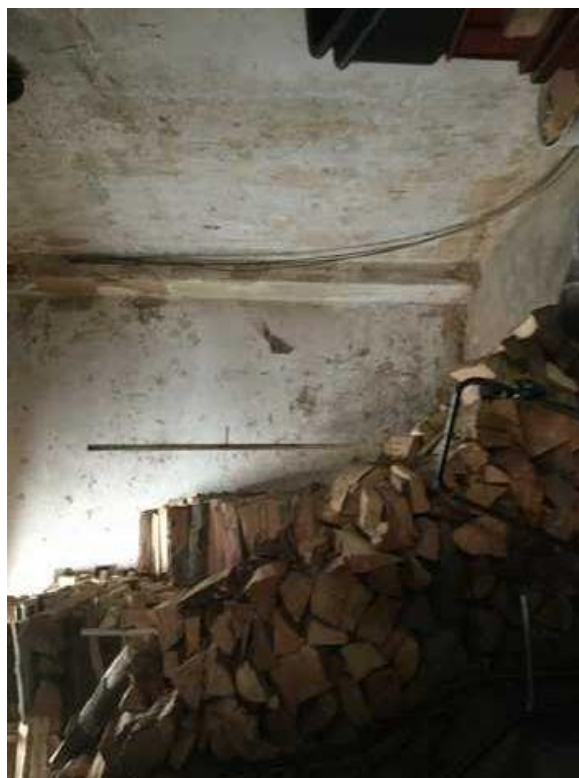
Stěny ve skladu
