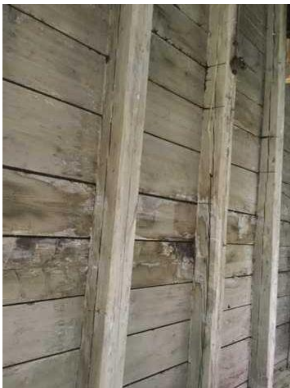
Dřevěný strop ve skladu
