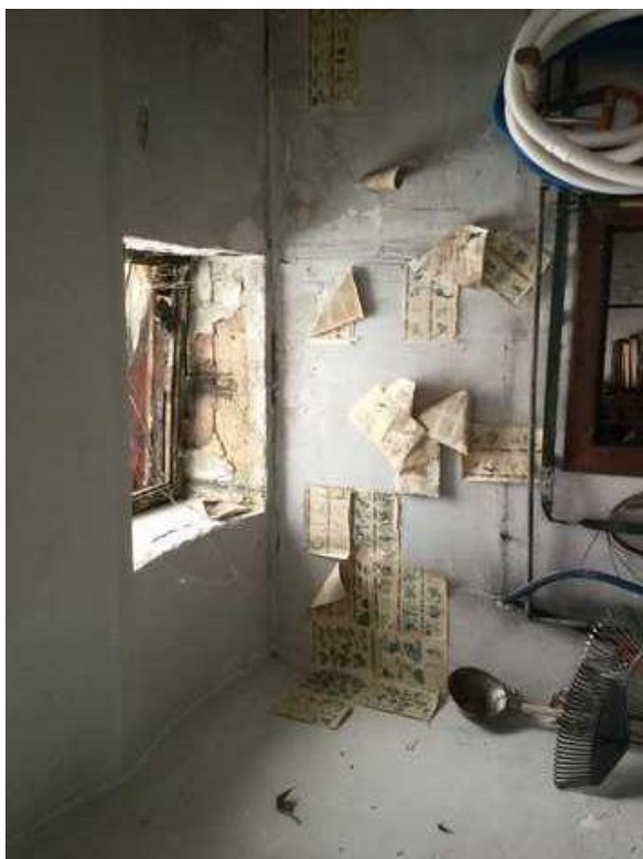
Strop se světlíkem
