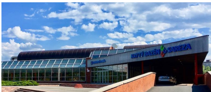
Obrázek 36 - Krytý bazén Sareza – pohled na hlavní vchod (zdroj: www.google.com )
