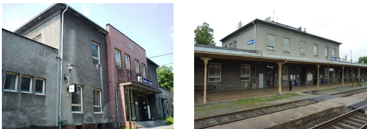
Obrázek 3 Pohled vstupu do budovy osobního nádraží a pohled od kolejíště
