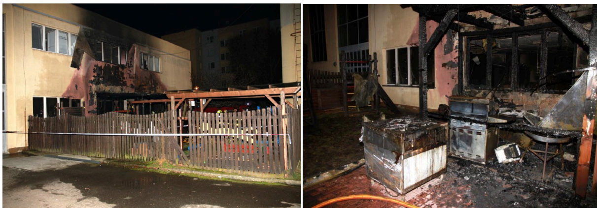
Záběry pořízené při vyšetřování požáru.
