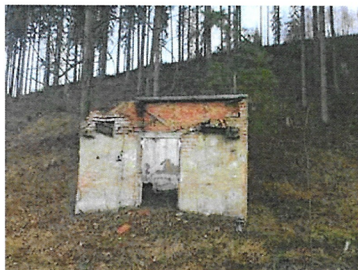
budova na pč. 117
