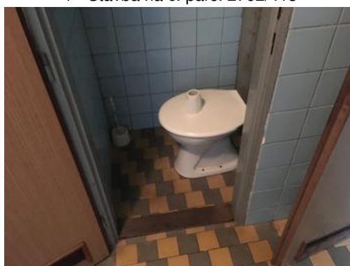
1 - Stavba na č. parc. 2702/413
