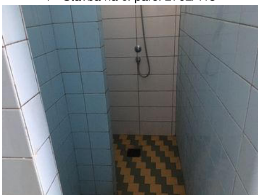
1 - Stavba na č. parc. 2702/413
