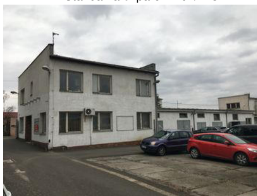
2 - Stavba na č. parc. 2702/412
