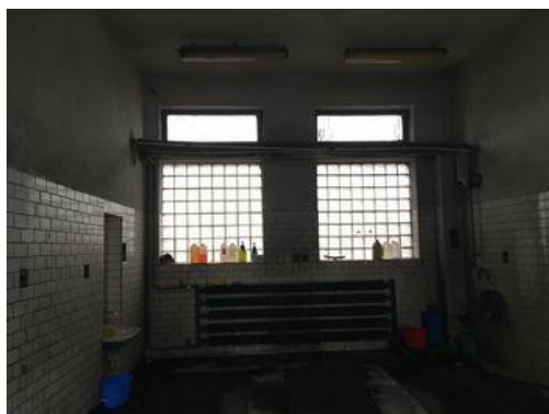
2 - Stavba na č. parc. 2702/412
