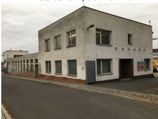
2 - Stavba na č. parc. 2702/412
