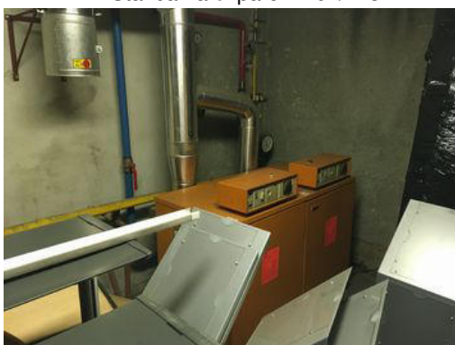
1 - Stavba na č. parc. 2702/413
