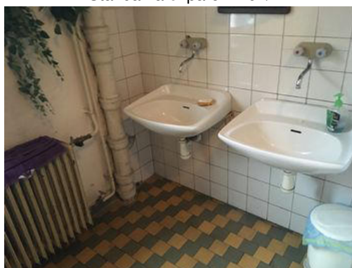
2 - Stavba na č. parc. 2702/412
