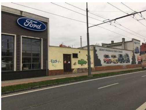
1 - Stavba na č. parc. 2702/413
