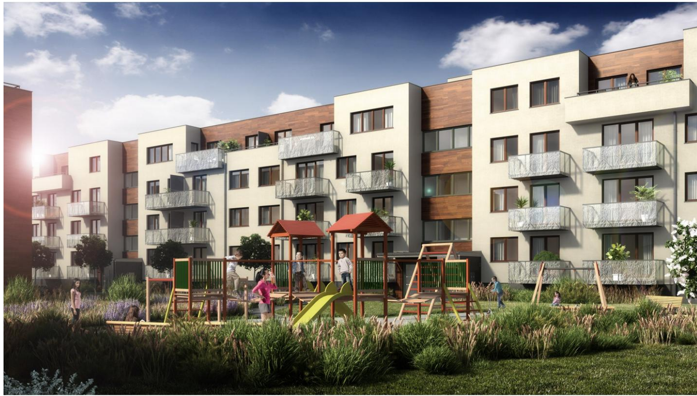
Byty Šibeník Olomouc – stavba zahájena www.bytsibenik.cz .
