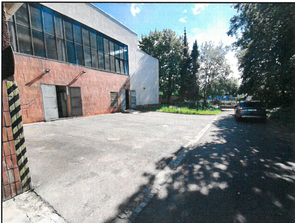
Fotodokumentace pořízená znaleckým ústavem na místním šetření dne 28. 7. 2020
