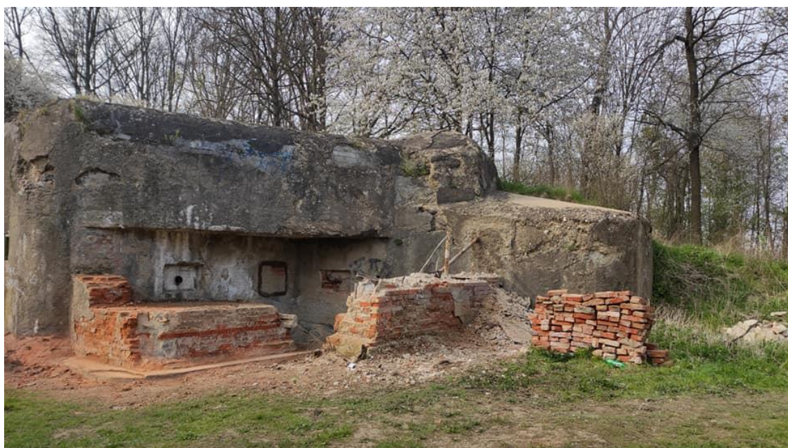
odklížení rozpadlé zdi a návrat exteriéru do podoby z prvné republiky
