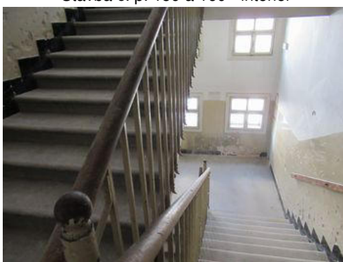
Stavba č. p. 159 a 160 - interiér
