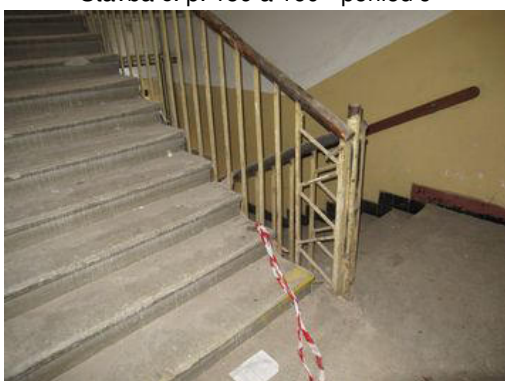
Stavba č. p. 159 a 160 - interiér
