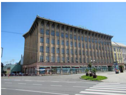
Stavba č. p. 159 a 160 - pohled Z
