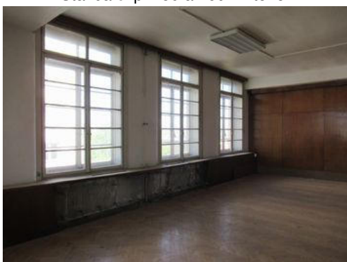
Stavba č. p. 159 a 160 - interiér
