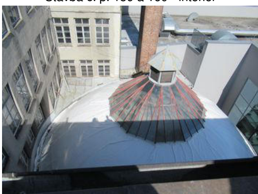
Stavba č. p. 159 a 160 - interiér
