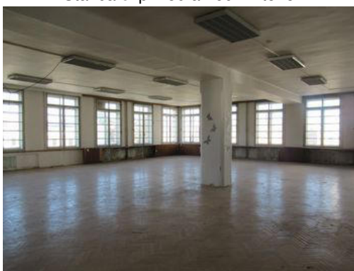
Stavba č. p. 159 a 160 - interiér
