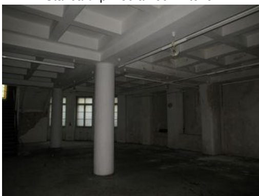
Stavba č. p. 159 a 160 - interiér
