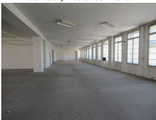
Stavba č. p. 159 a 160 - interiér
