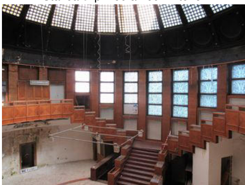
Stavba č. p. 159 a 160 - interiér
