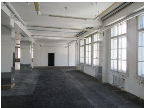
Stavba č. p. 159 a 160 - interiér
