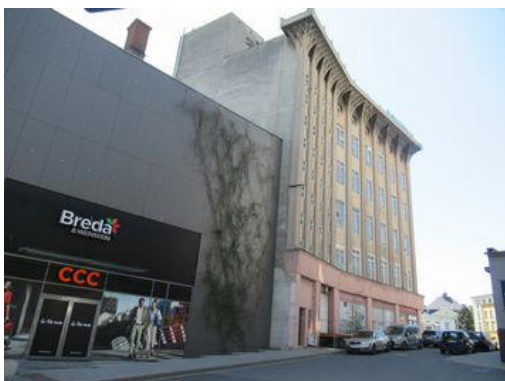
Stavba č. p. 159 a 160 - pohled S
