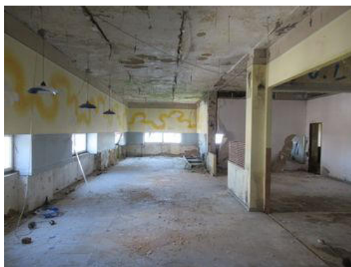
Stavba č. p. 159 a 160 - interiér
