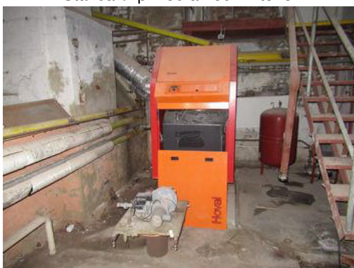
Stavba č. p. 159 a 160 - interiér
