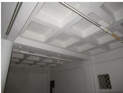
Stavba č. p. 159 a 160 - interiér
