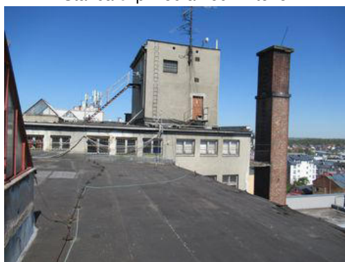
Stavba č. p. 159 a 160 - interiér
