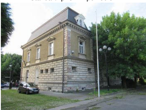
Stavba č. p. 314 - pohled SV
