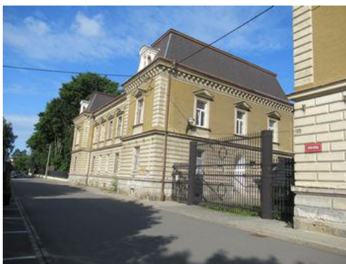
Stavba č. p. 314 - pohled JV
