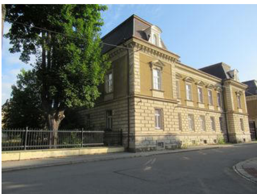
Stavba č. p. 314 - pohled JZ
