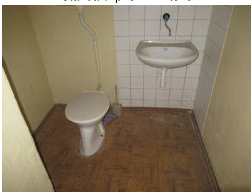
Stavba č. p. 314 - interiér
