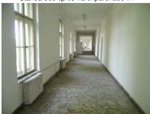
Stavba bez čp/če na č. parc. 2204/7
