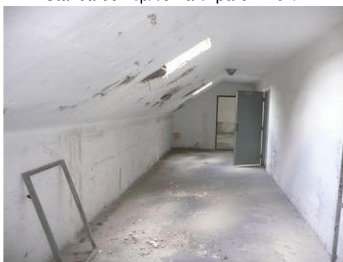
Stavba bez čp/če na č. parc. 2204/7
