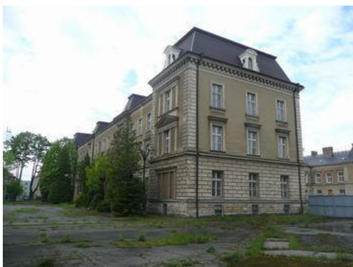
Stavba bez čp/če na č. parc. 2204/7
