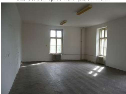
Stavba bez čp/če na č. parc. 2204/7
