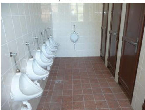
Stavba bez čp/če na č. parc. 2204/7
