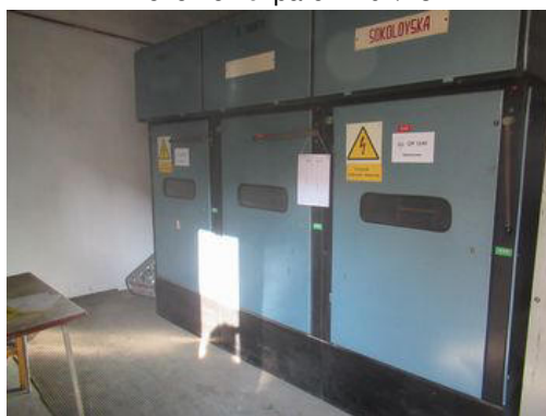
Stavba na č. parc. 2204/11
