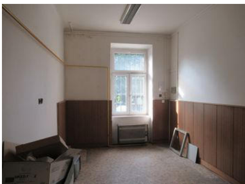
Stavba č. p. 314 - interiér
