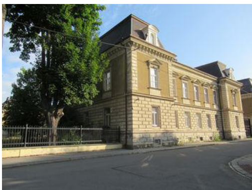
Stavba č. p. 314 - pohled JZ
