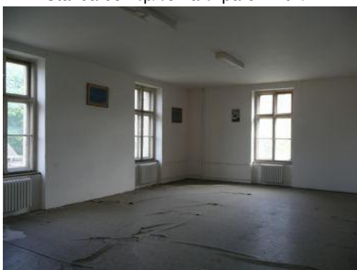
Stavba bez čp/če na č. parc. 2204/7
