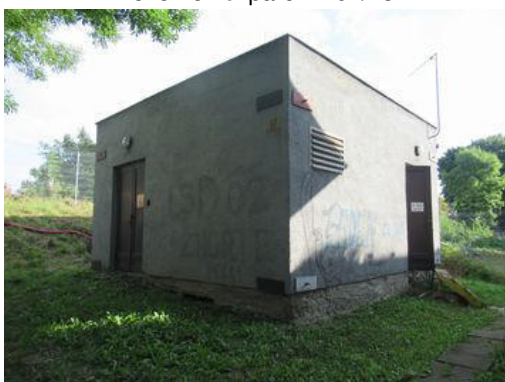
Stavba na č. parc. 2204/11
