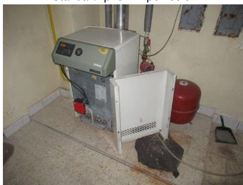
Stavba č. p. 314 - interiér
