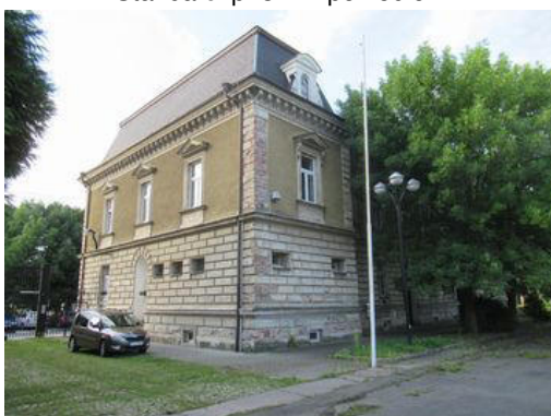
Stavba č. p. 314 - pohled SV
