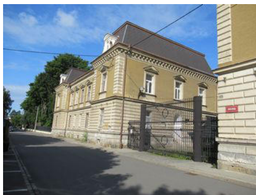
Stavba č. p. 314 - pohled JV
