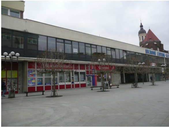
Stavba na č. parc. 265/4 a 260/4 - pohled SV
