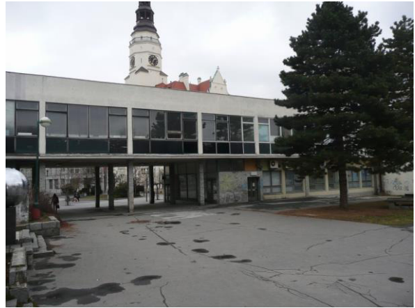
Stavba na č. parc. 265/4 a 260/4 - pohled JZ
