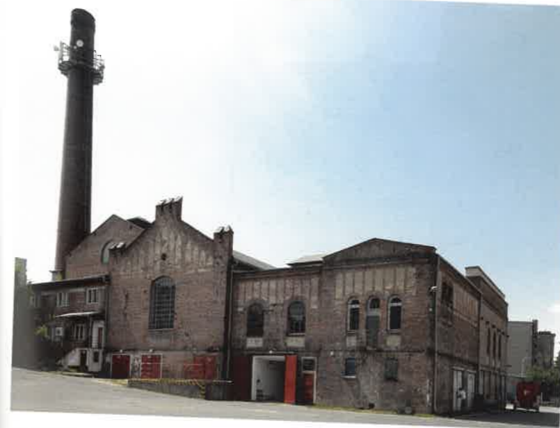
Krnovská ulice, Předměstí Rudolf Laube, realizace Alois Geldner, 1903-1904; rozšíření Roman Kuba, Evžen Kuba, 1988 Rudolf Laube, building contractor Alois Geldner, 1903-1904; extension Roman Kuba, Evžen Kuba, 1988
