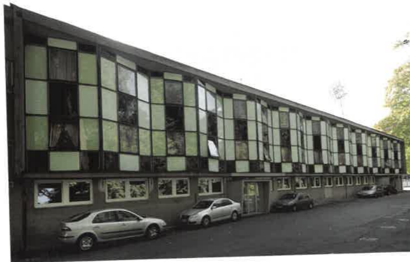
Lipová 2, Předměstí čp. 105 Miroslav Selinger, interiéry VI. Výtisk, 1966-1974; Bytprům Opava, 1980-1984 Miroslav Selinger, interiors by V. Výtisk, 1966-1974; Bytprům Opava, 1980-1984
