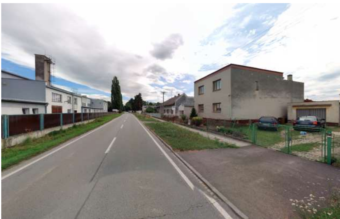
silnice II/464 v intravilánu MČ Opava – Kylešovice se stáv. chodníkem v místě plánované cyklostezky
