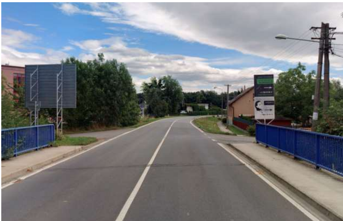
silnice II/464 na začátku úpravy (vč. části mostního objektu přes řeku Moravici)
